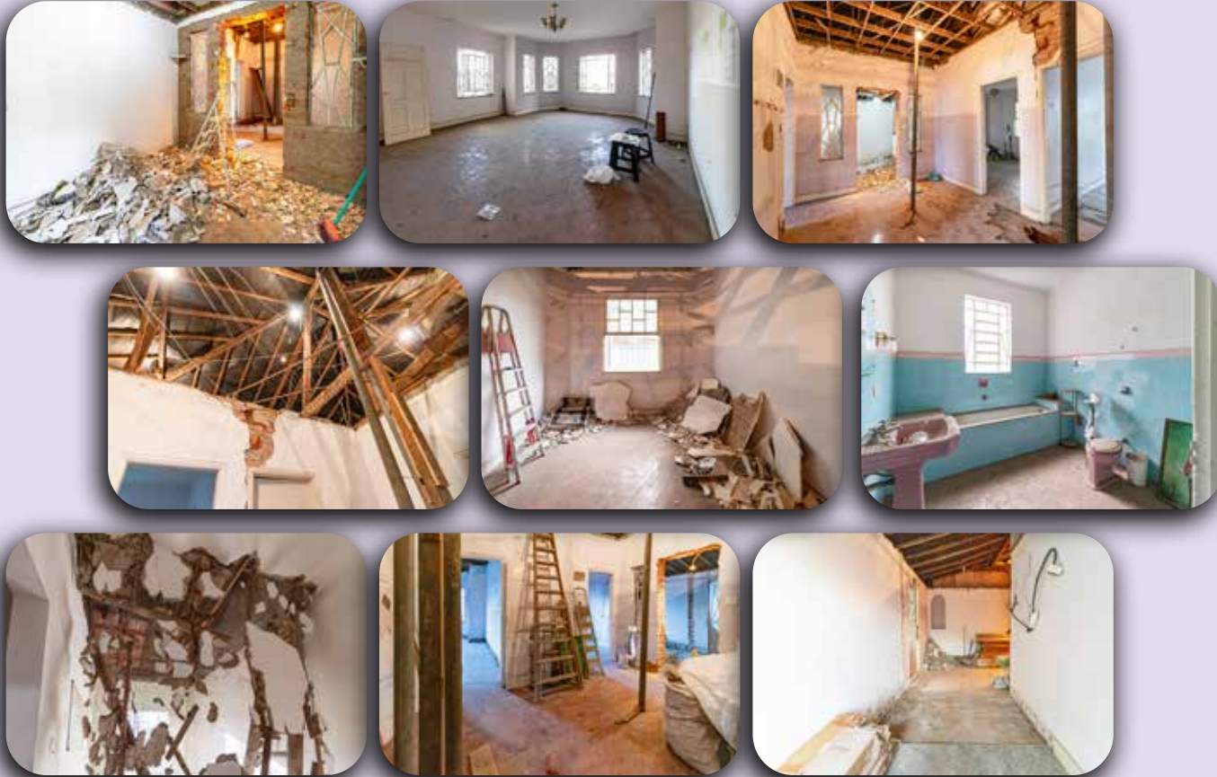
Início da obra no Café Memorial.
