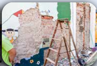
Reforma no muro da CEI São Francisco.
