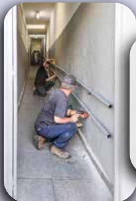
Reparo nos corrimões da sede.
