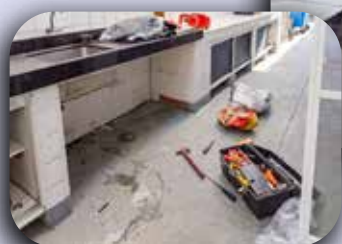
Conserto de pia e telhado na CEI São José.
