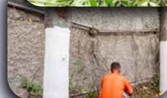
Manutenção da tubulação da rede elétrica.
