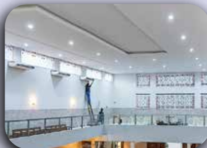
Troca das luminárias queimadas e detetização dos equipamentos do ar-condicionado na Capela.
